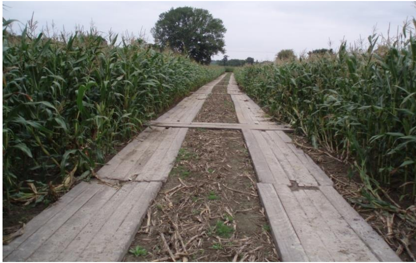
Abbildung 7: Temporäre Zuwegung über Fahrbohlen
