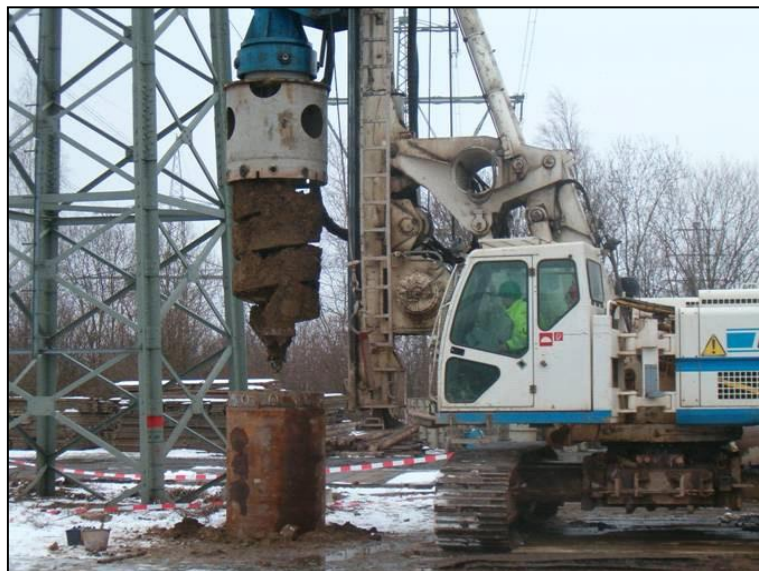
Abbildung 9: Bohrung für einen Bohrpfahl
