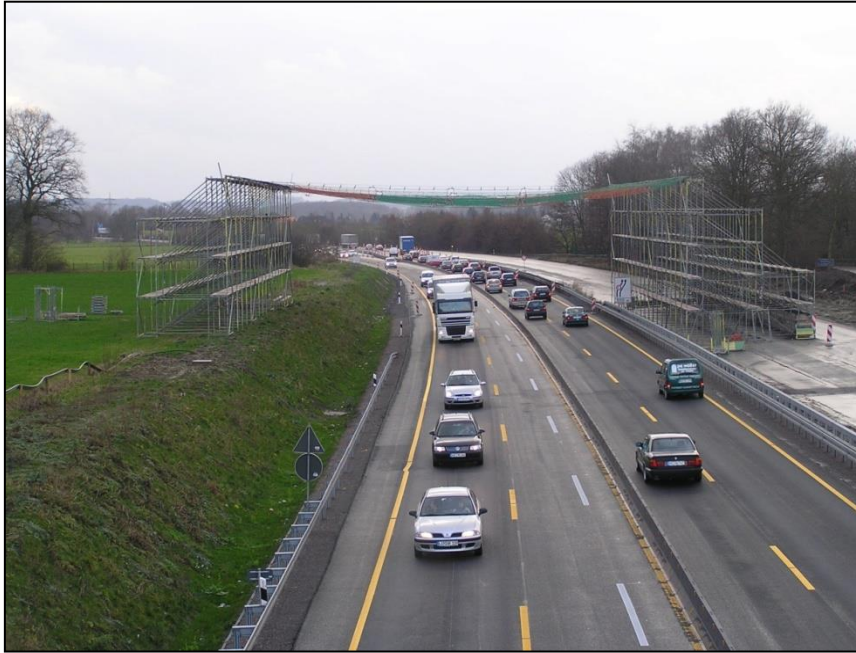
Abbildung 13: Stahlrohrschutzkonstruktion mit Netz über einer Autobahn
