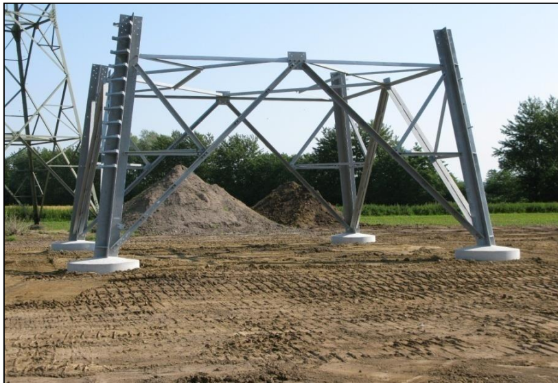
Abbildung 10: Montierter Mastfuß
