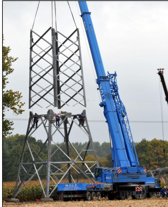
Abbildung 11: Mastmontage (Stocken)
