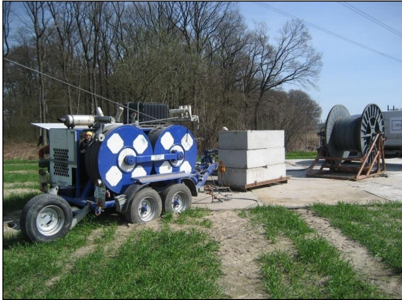
Abbildung 14: Windenplatz eines 4er-Bündel-Seilzuges
